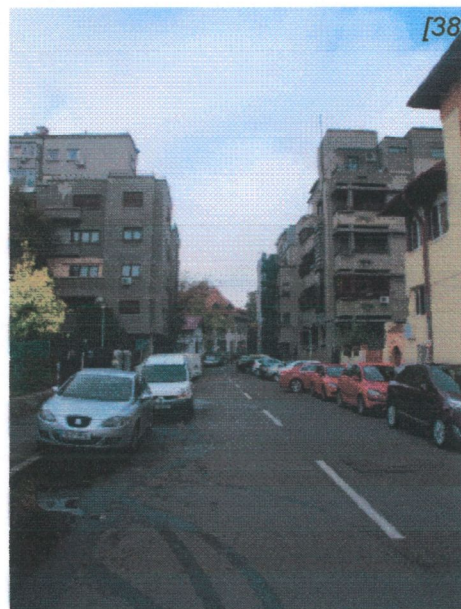
[40] Vedere de ansamblu a construcției analizate.
