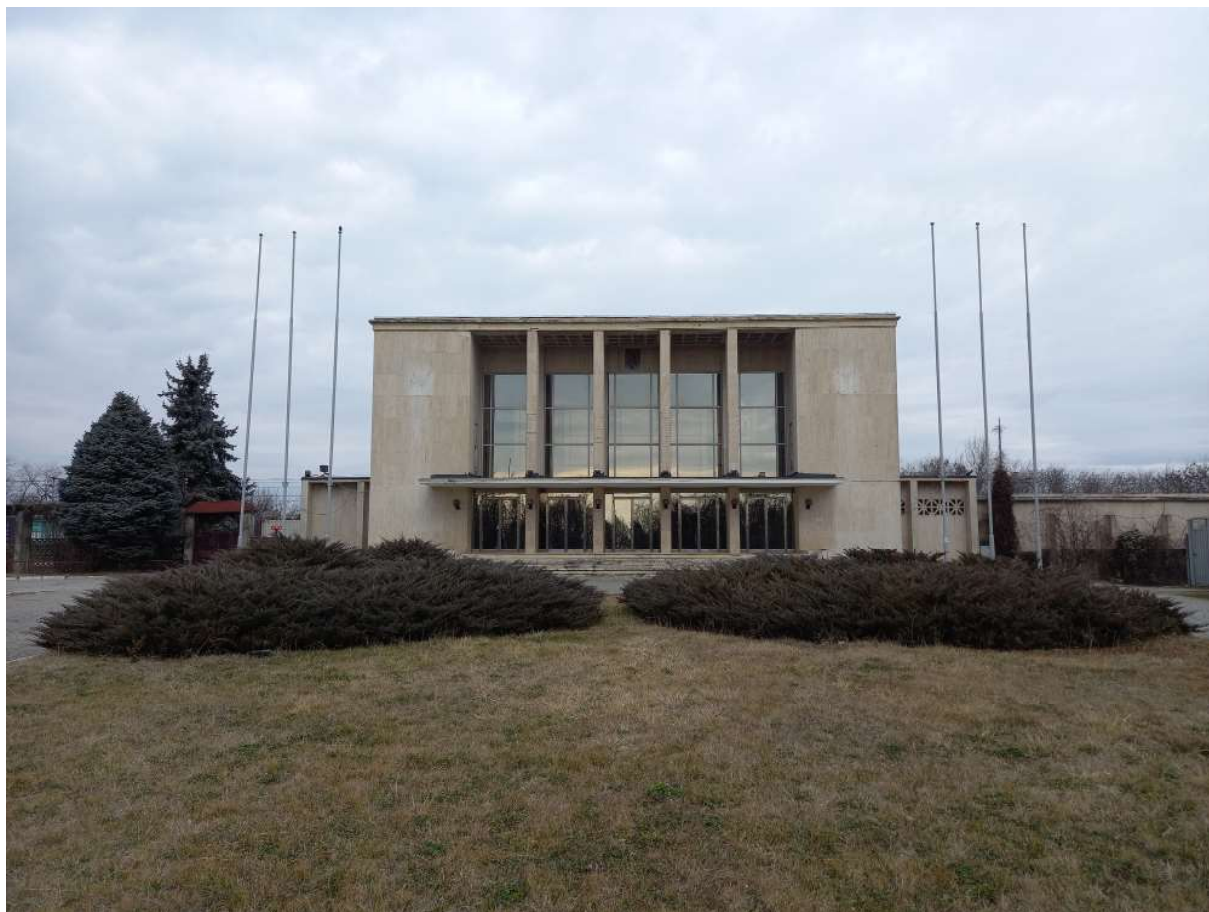
[Fig. 60] Fațada principală a Gării regale de la Băneasa. Se observă tratarea monumentală a volumului prin utilizarea simetriei, pilelor verticale dezvoltate pe o înălțime mare, panta terenului contribuind la susținerea aceleiași idei.
