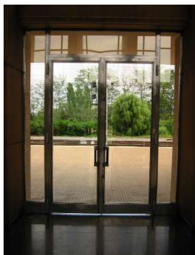
[Fig. 70] Tâmplăriile exterioare ale ușilor sunt realizate din profile metalice căptușite cu tablă de inox.
