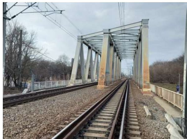
[Fig. 58] Structura metalică a noului pod peste Șoseaua București-Ploiești.
