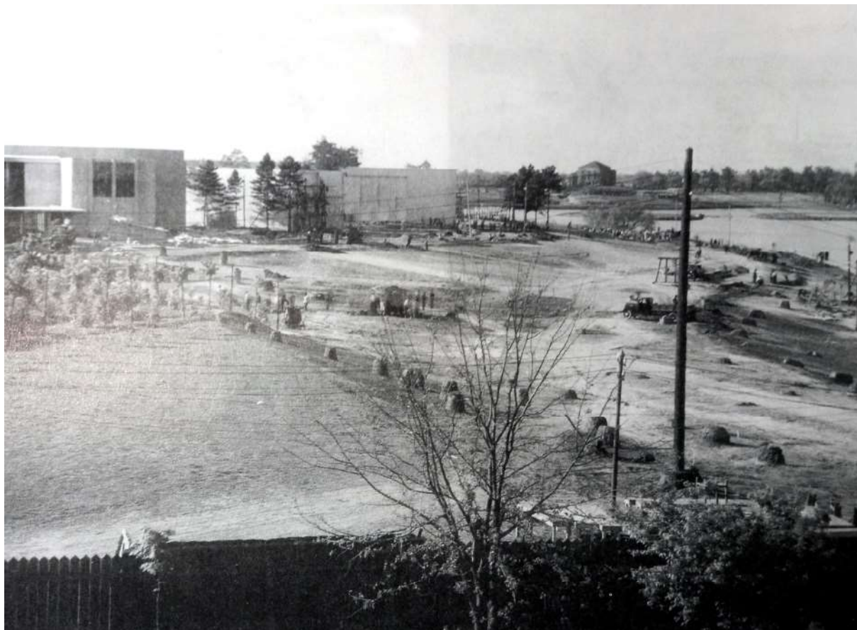
[Fig. 20]. Amenajarea malului Lacului Herăstrău cu ocazia desfășurării „Lunii Bucureștilor”, inițiativă a primarului Alexandru G. Donescu sprijinită de regele Carol al II-lea. În plan secund se văd ruinele palatului Văcărescu, dar și profilul acoperișului vilei Minovici (Ionel C. Ioniță, O „lună” din istoria Bucureștilor, București, Arcub, 1998, p. 68).
