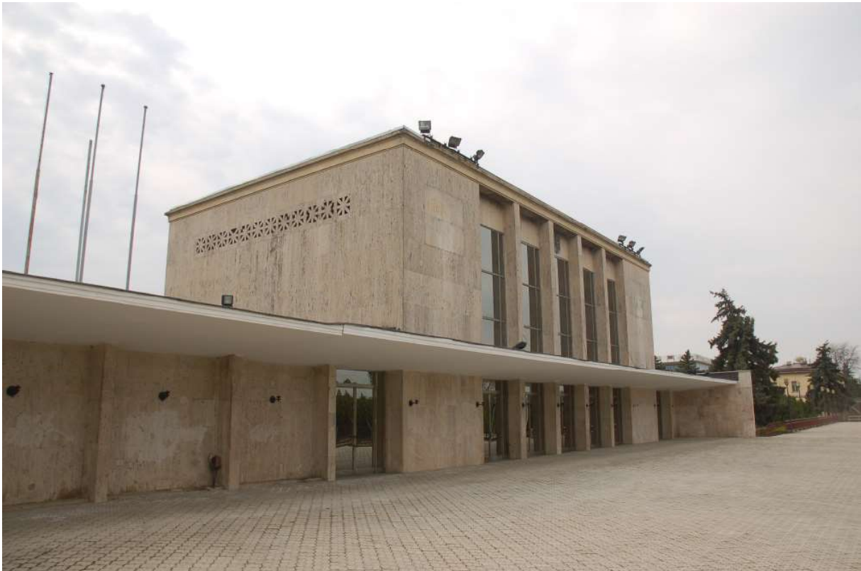
[Fig. 83] Gara regală de la Băneasa cuprinde elemente urbanistice, arhitecturale și artistice de valoare excepțională.
