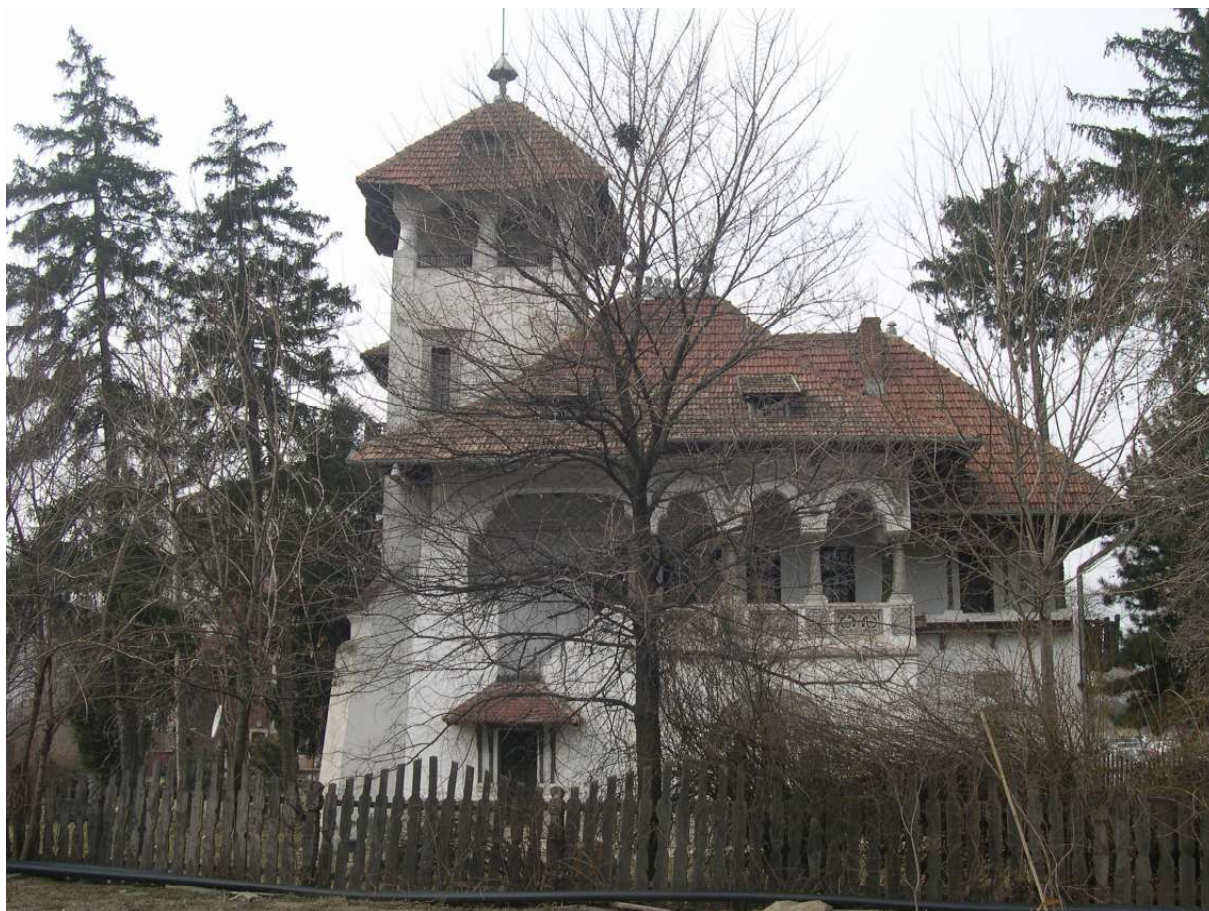
[Fig. 82] Casa doctorului Nicolae Minovici, construită la începutul secolului al XIX-lea după proiectul lui Cristofi Cherchez a devenit un reper important al zonei. Fotografie realizată înainte de ultima restaurare.
