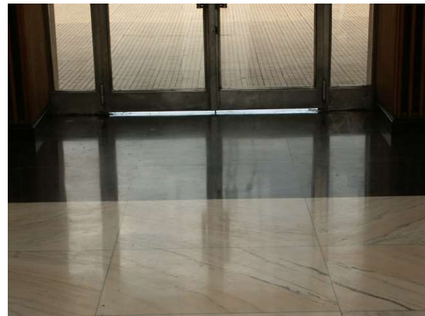
[Fig. 68] Perimetrul pardoselii salonului oficial este realizat din marmură neagră de Belgia, în timp ce câmpul este din marmură de Rușchița.
