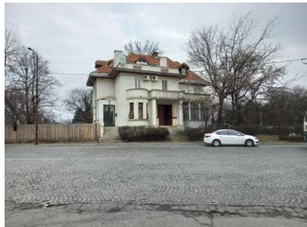
[Fig. 78] Clădirea din Strada Nicolae Minovici, Nr. 2, construită în 1927. Aproximarea de Gara regală a determinat autoritățile să i-a în calcul desființarea ei. Cum acest lucru nu s-a petrecut, în ilustrațiile de epocă construcția apare în permanență cuprinsă de o vegetație bogată.
