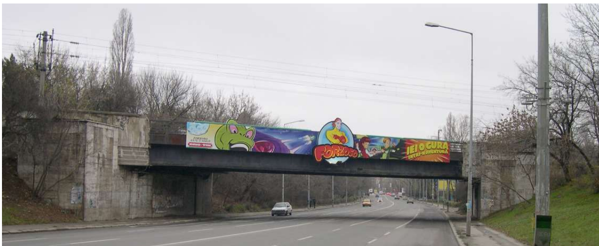
[Fig. 59] Podul construit în perioada interbelică pregătit pentru demolare.
