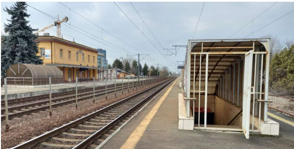
[Fig. 56] Pasajul pietonal subteran realizat prin proiectul de „Reabilitare a liniei de cale ferată București – Constanța secțiunea București Băneasa – Fundulea”. Volumele propuse sunt mai degrabă rezultatul unor propuneri funcționale, fără preocupări estetice.
