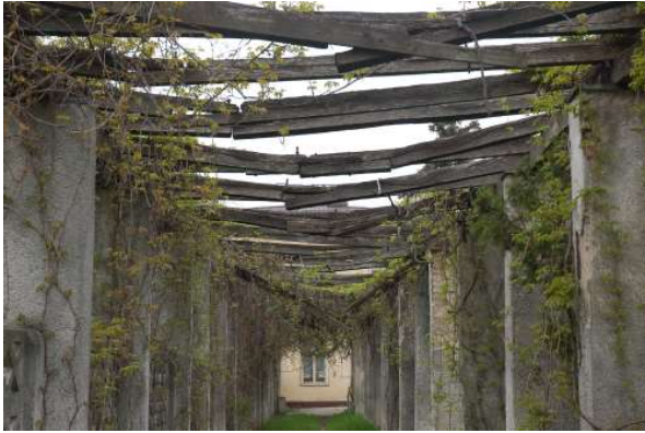
[Fig. 74] Pergola de lemn dintre cele două gări este aproape distrusă de intemperii.
