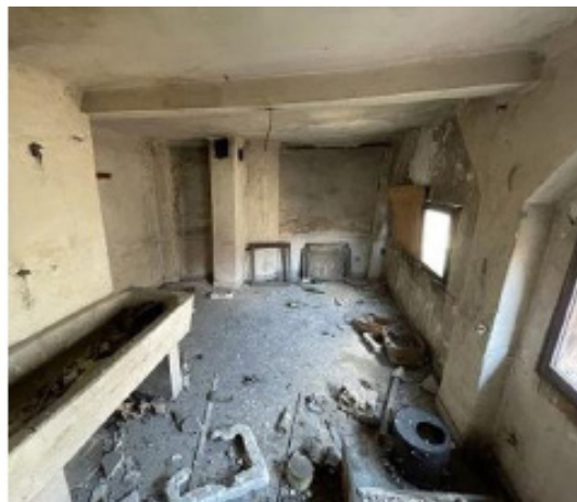
Pod circulabil și spălătorie – structura din lemn și tencuieli atacate de umezeală
