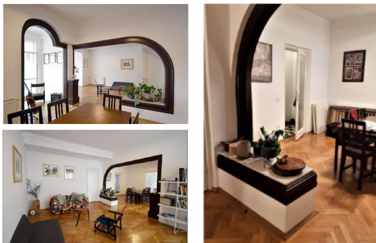
Apartament et.5 cu intervenții arhitectural - decorative (probabil ulterioare) de înlocuire a glasvandurilor spre living și seră cu arcade încadrate de rame din ipsos vopsit
