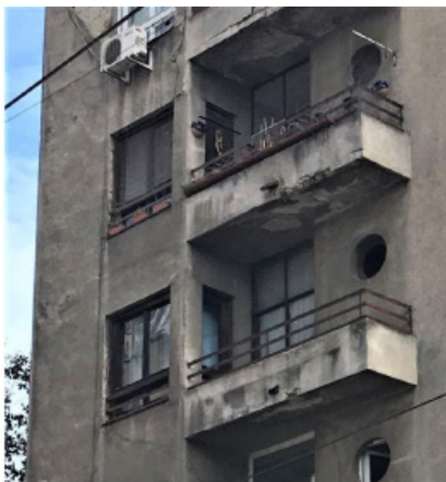
Parapete de balcon spre Calea Moșilor
