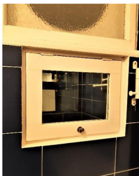
Scândură de călcat rabatabilă încastrată în peretele oficiului (apartament et. 5)
