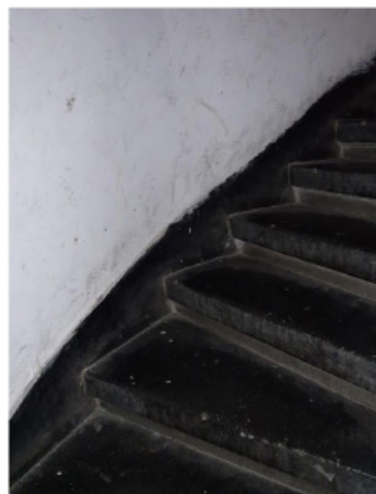
Trepte și plinte scara etaj – mozaic turnat
