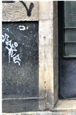
Materiale demisol – granit, calcar, tencuială
