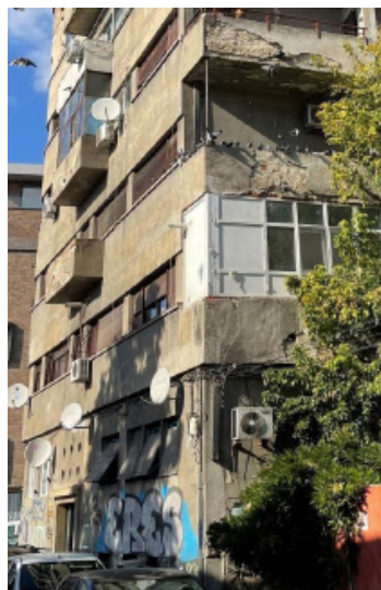
Fisuri în zidărie, tencuieli exterioare căzute sau exfoliate, graffiti parter, balcoane închise Consolidare post-1977 în zona de colț (st.) Zid de sprijin al curții de serviciu distrus (st. jos)
