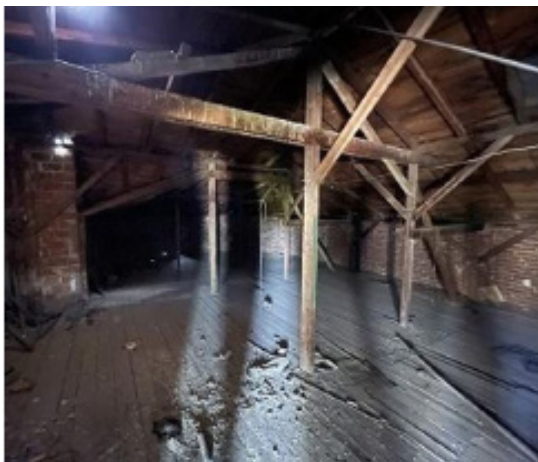
Pod circulabil și spălătorie – structura din lemn și tencuieli atacate de umezeală
