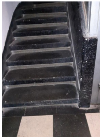
Trepte și plinte scara parter – mozaic turnat
