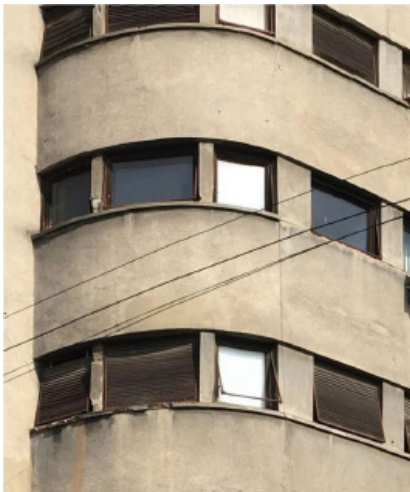
Tencuieli de fațadă și tâmplării exterioare
