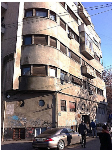
Vedere din intersecție
