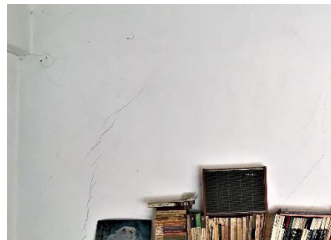
Etajeră ipsos armat cu lemn (apartament et. 3)
